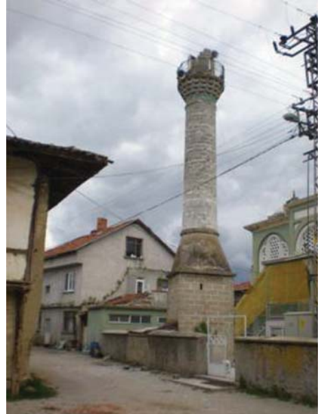
Şekil 3 - Depremde oluşan minare hasarlarından bir görünüm
