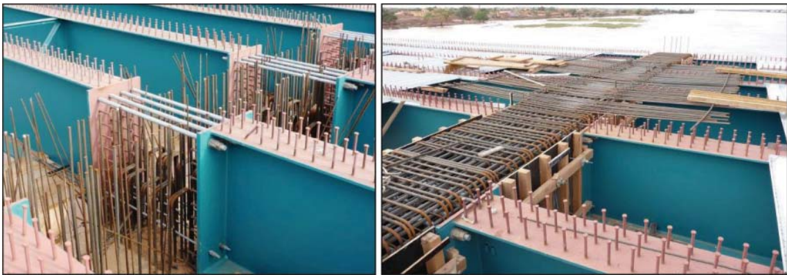
Şekil 11 - Çelik-beton kompozit üstyapı ile ayaklar arasında rijit birleşim teşkil edilmesi.
