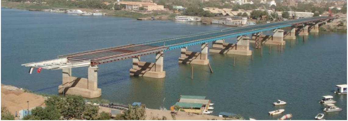
Şekil 9 - El Mek Nimir Köprüsü'nde ardışık itme ile çelik kirişlerin yerleştirilmesi.
