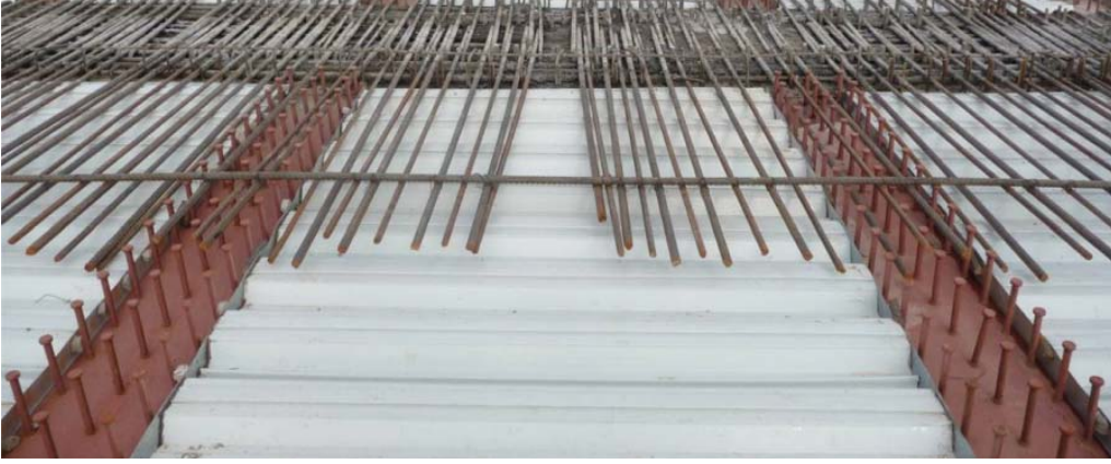
Şekil 7 - Al Halfaia Köprüsü'nde ana kirişler arasında trapez sac kalıplarının montajı.
