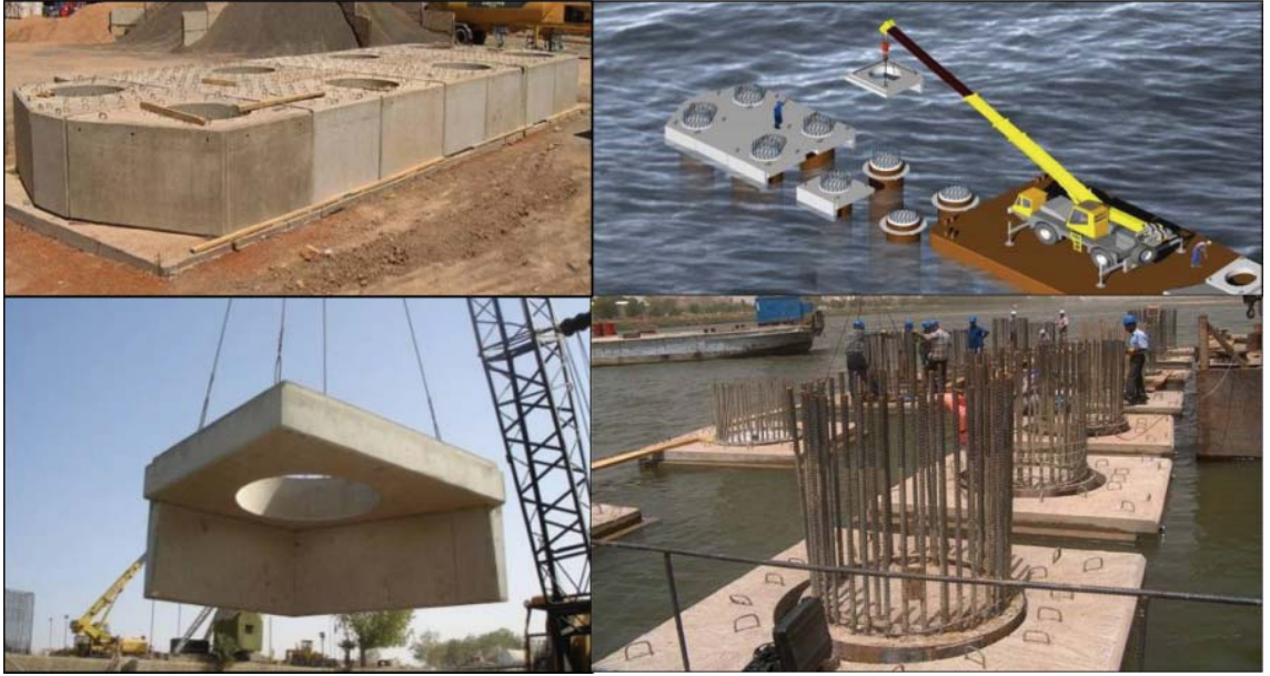
Şekil 5 - Prekast Kazık Başlığı Kalıplarının montajı.
