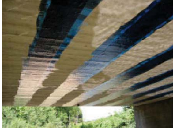
Şekil 6 - Köprü Döşemesinde CFRP uygulaması [10]
