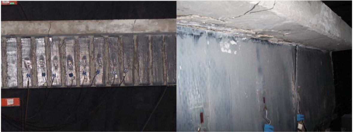
Şekil 1 - CFRP kompozit kullanılarak kesme dayanımının artırılması uygulamaları
