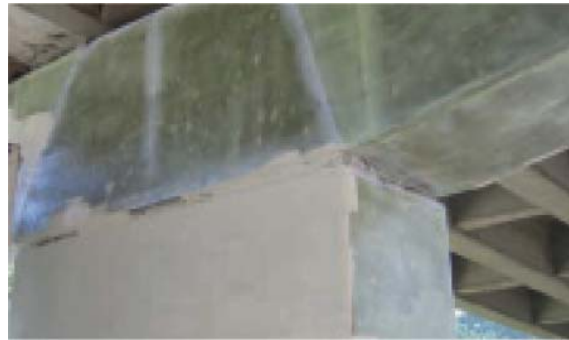
Şekil 5 - Kolon kiriş birleşim bölgesinde CFRP uygulaması [9]
