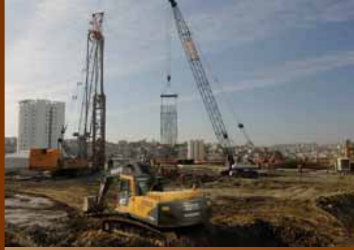
Ülker Arena Baret Temelleri, Ataşehir - İstanbul
