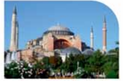
AYASOFYA MÜZESİ Deprem Güvenliği Tespiti Projesi / İstanbul
