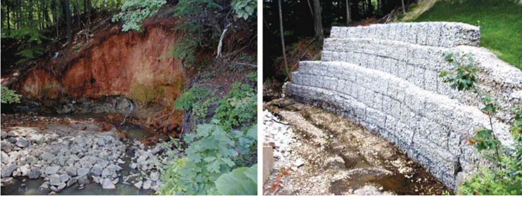
Şekil 10 - Erozyonlu bölgede gabion uygulaması (N.Carolina) öncesi ve sonrası (Maccaferri, 2010)
