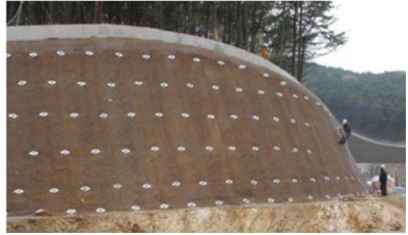
Şekil 2 - Çivi düzenlemesi ile genel profil (solda) ve şaşırtmalı düzen ile çivi montajı yerleşimi - Dongcheon Projesi, Kore (sağ).
