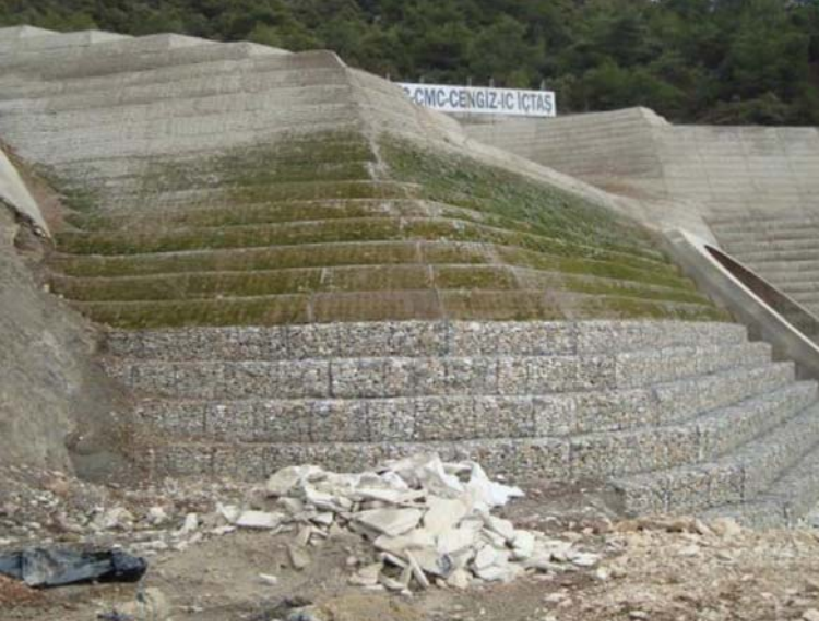
Şekil 18 - Ankara-İstanbul 2. Etap Hızlı Tren Projesi yeşillendirilmiş gabion sepet uygulaması (TeknoÇevre web sayfası, 2012)
