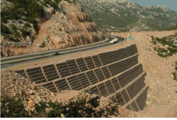
Şekil 8 - Gabion dayanma duvarı uygulaması (Vikipedi, SvetiRok, Croatia)
