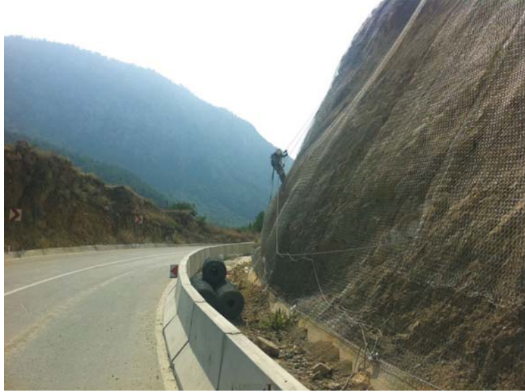
Şekil 7 - Bozüyük - Mekece Yolu Şevde Kaya ve Taş Düşmelerine Karşı Çelik Grid Uygulaması (Tekno Maccaferri web sayfası, 2011)
